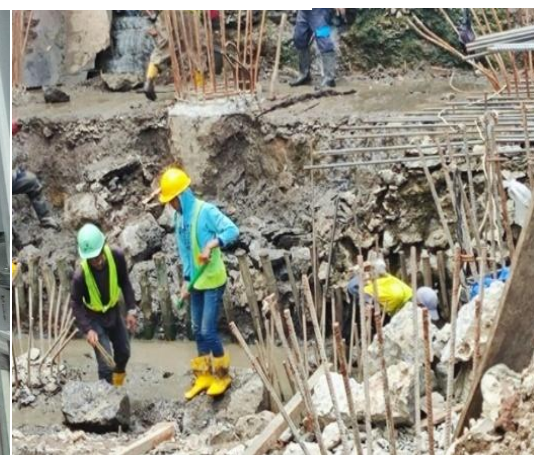
Gambar 6. Pekerjaan Pembesian Pile Cap
