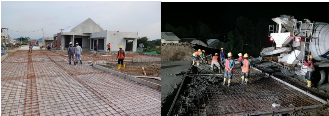
Gambar 1. Pekerjaan Pembesian Sumber : Data Proyek, 2024
