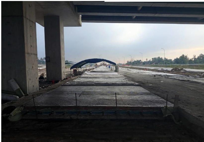
Gambar 3. Pengecoran Rigid Pavement Sumber : Data Proyek, 2024
