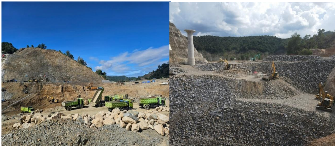
Gambar 4. Pekerjaan Timbunan Tanah Sumber : Data Proyek
