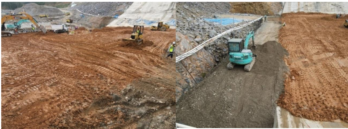
Gambar 5. Pekerjaan Timbunan Tanah Sumber : Data Proyek
