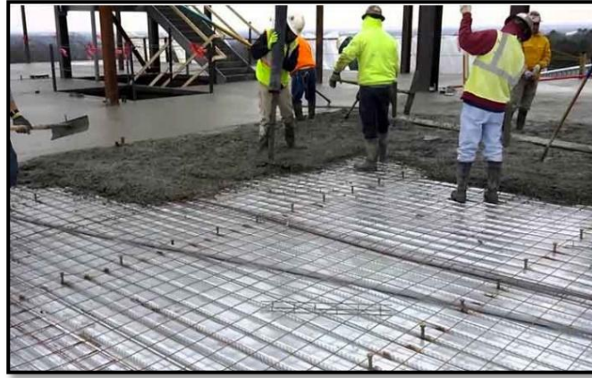
Gambar 7. Pekerjaan Pengecoran Kolom dan Plat
