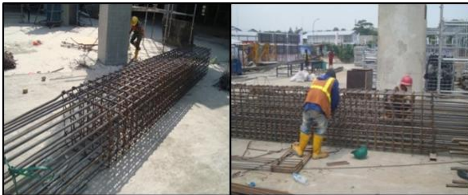
Gambar 4. Proses Fabrikasi Kolom dan Plat
