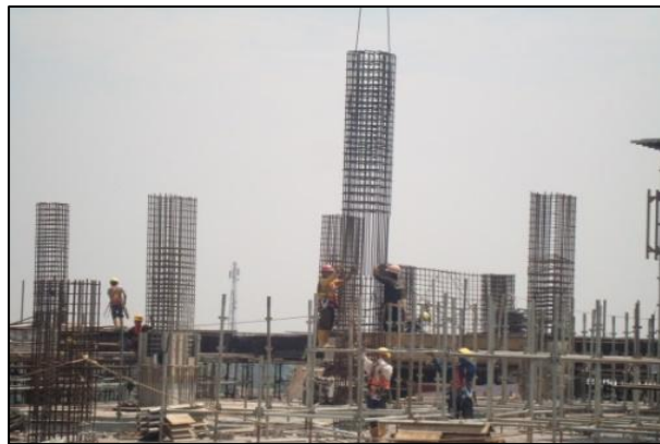
Gambar 5. Pekerjaan Kolom dan Plat
