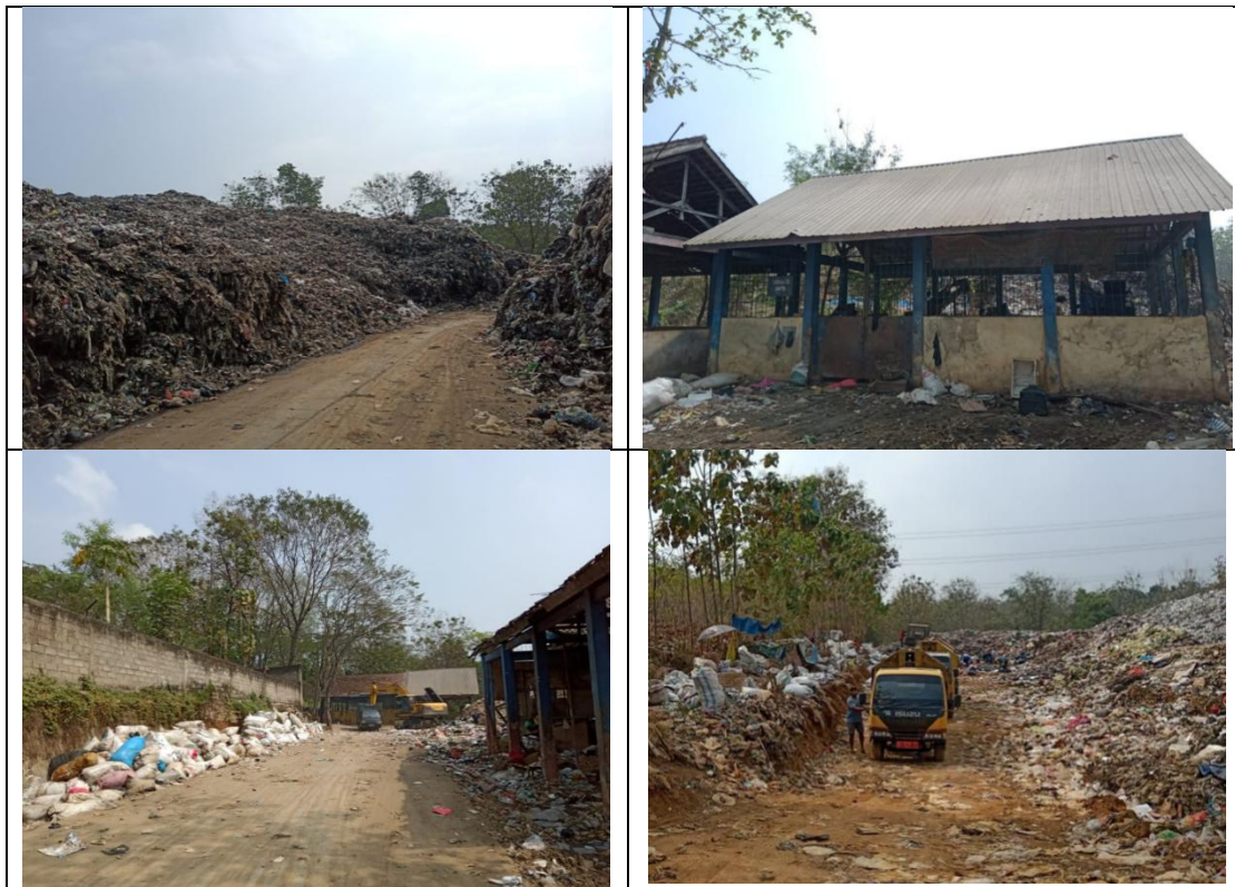
Gambar 3. Sarana Pengolahan dan Pemrosesan Akhir
