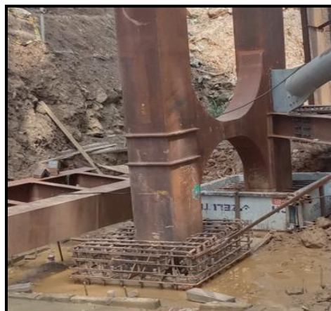
Gambar 6. Pemasangan Tulangan Cangkang
